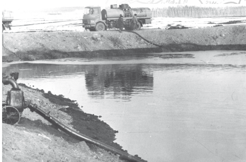
Прорыв нефтепровода в районе пос. Тыреть. 1993 г.
