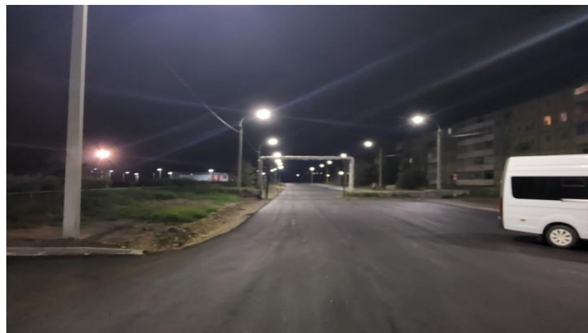
Ремонт автомобильной дороги в п. Тыреть
